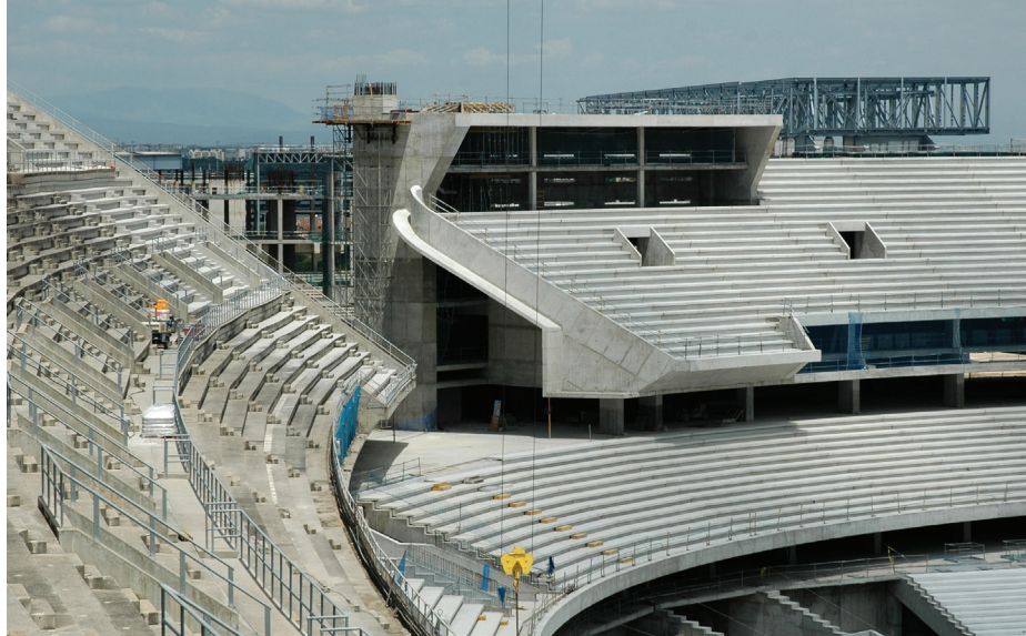
Obras del nuevo estadio del Atlético de Madrid (Madrid).
